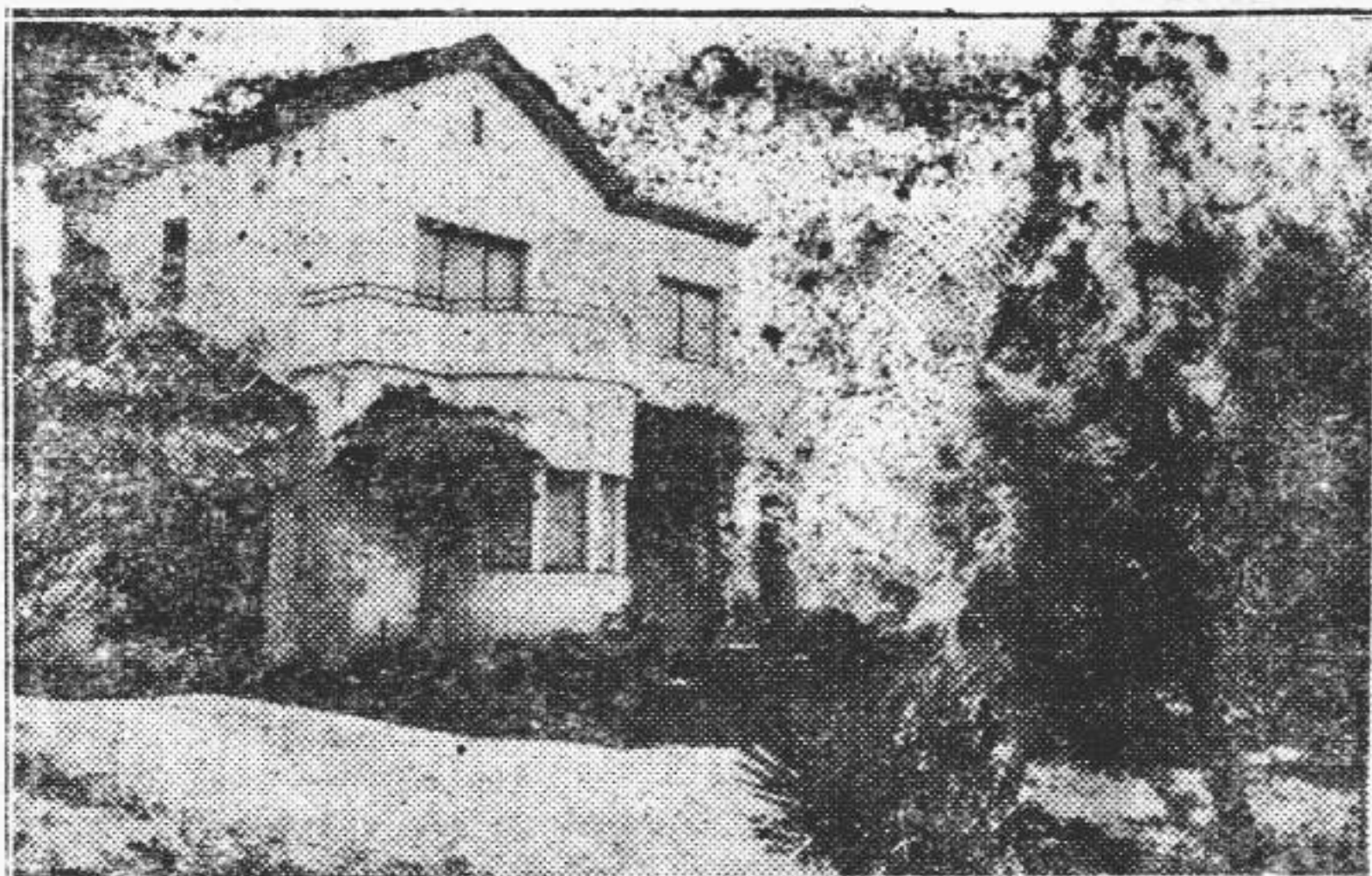
Chalet construido en el Parque
