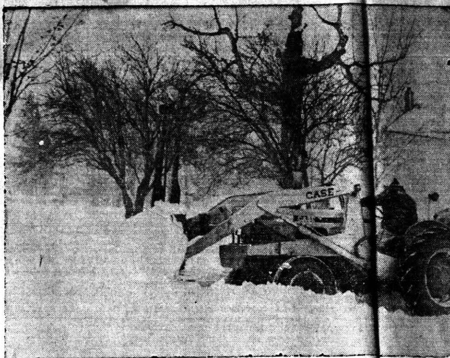
50 PULGADAS — Un obrero comienza a despejar las calles de frecuencia, Nueva York, después que una tormenta de dos días depositó 50 pulgadas de nieve sobre esa área. Cientos quedaron aisladas cuando un tramo de 41 millas de carretera fue cerrado al tránsito.
